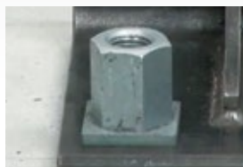
③ ロングネジナット本体をセットし、トルクレンチで規定値まで締め込みます。
