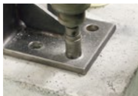
① 被締結体に拡大孔を設けます。▶ Aタイプと同じ施工手順になります。
